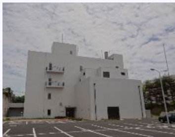
治療装置を設置している「いばらき中性子医療研究センター」（茨城県東海村）
