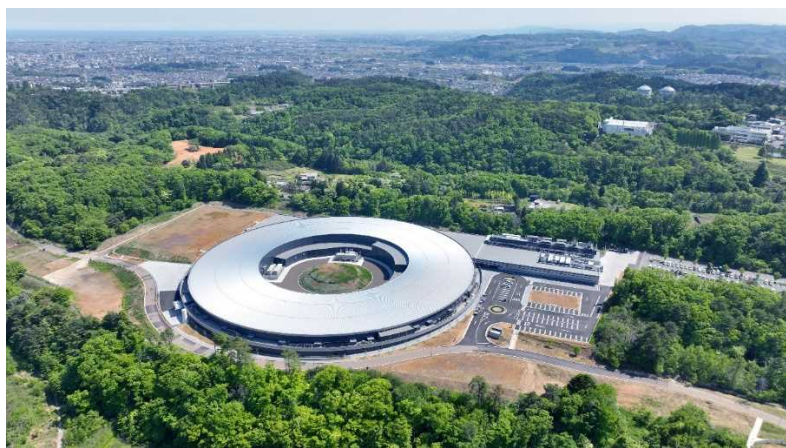
図:東北大学の青葉山新キャンパスに建設されたナノテラス全景
