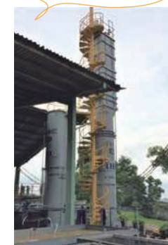
マレーシアに設置しているOPT利活用技術実証設備。高品質OPTペレットをはじめ、バイオガス生産・発電、水処理設備を備え、ゼロエミッションでOPTから高付加価値製品を製造する。
