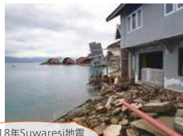
2018年Suwarsi地震津波による被害
