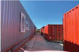
水素インフラセンターの屋外施設、 コンテナを活用し、様々な研究を行っている。 新アンモニア製造装置も同様に格納予定。
