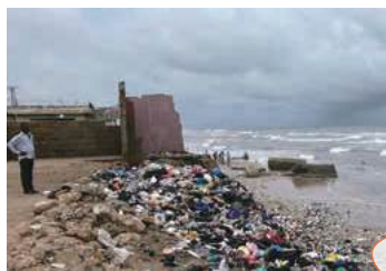
海岸侵食による家屋の崩壊とゴミの流出 (Densu Delta)
