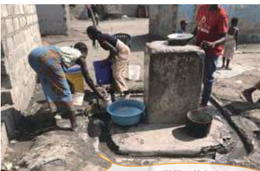
20~30世帯で共有する 屋外の水道水栓で水を汲む様子。 水圧が低いため、蛇口は地面スレスレにある。 汲んだ水は家で溜められるが 飲むまでに汚染がすすむ。
