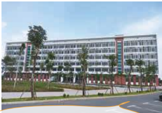
Hoa Lac地区VNU新棟の分析R&Eセンター (本プロジェクトの技術開発、人材育成拠点)
