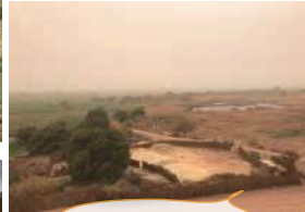
ダフラ・オアシス 西地域 畑に点在する排水池
