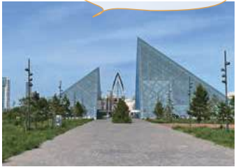
VRシアターを設置する ナザルバエフ大学の建物外観
