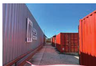
水素インフラセンターの屋外施設。コンテナを活用し、様々な研究を行っている。新アンモニア製造装置も同様に格納予定。
