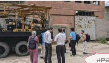
井戸掘削技術の調査
