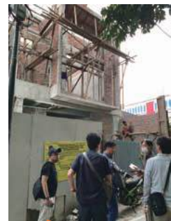
組積造住宅の建築現場の視察
